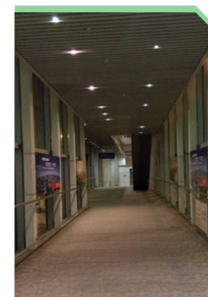
T3 登机桥固定端 LED 光源及照明控制系统
